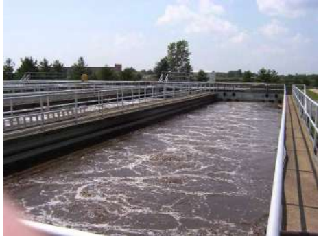
บ่อบำบัดน้ำเสีย
