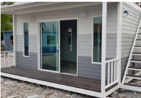
บ้านประกอบเสร็จ
